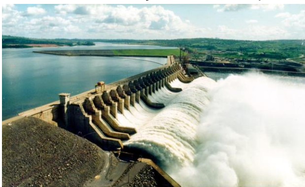
UHE – Tucuruí – Planejamento do Concreto de Segunda Etapa de Ampliação das Obras
