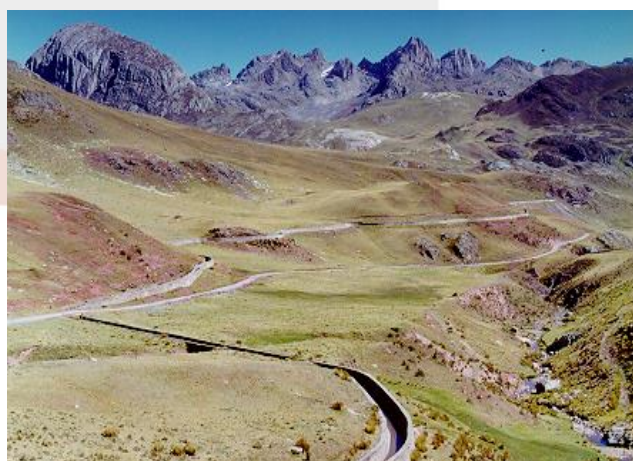
Canal de Adução para abastecimento da Cidade de Lima – Perú – Aumento da Capacidade
